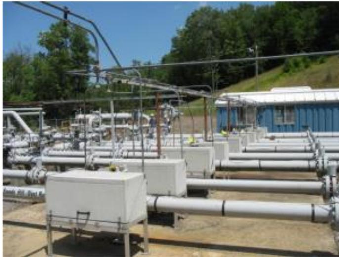
**Figure 10. Example Meter Runs.**
